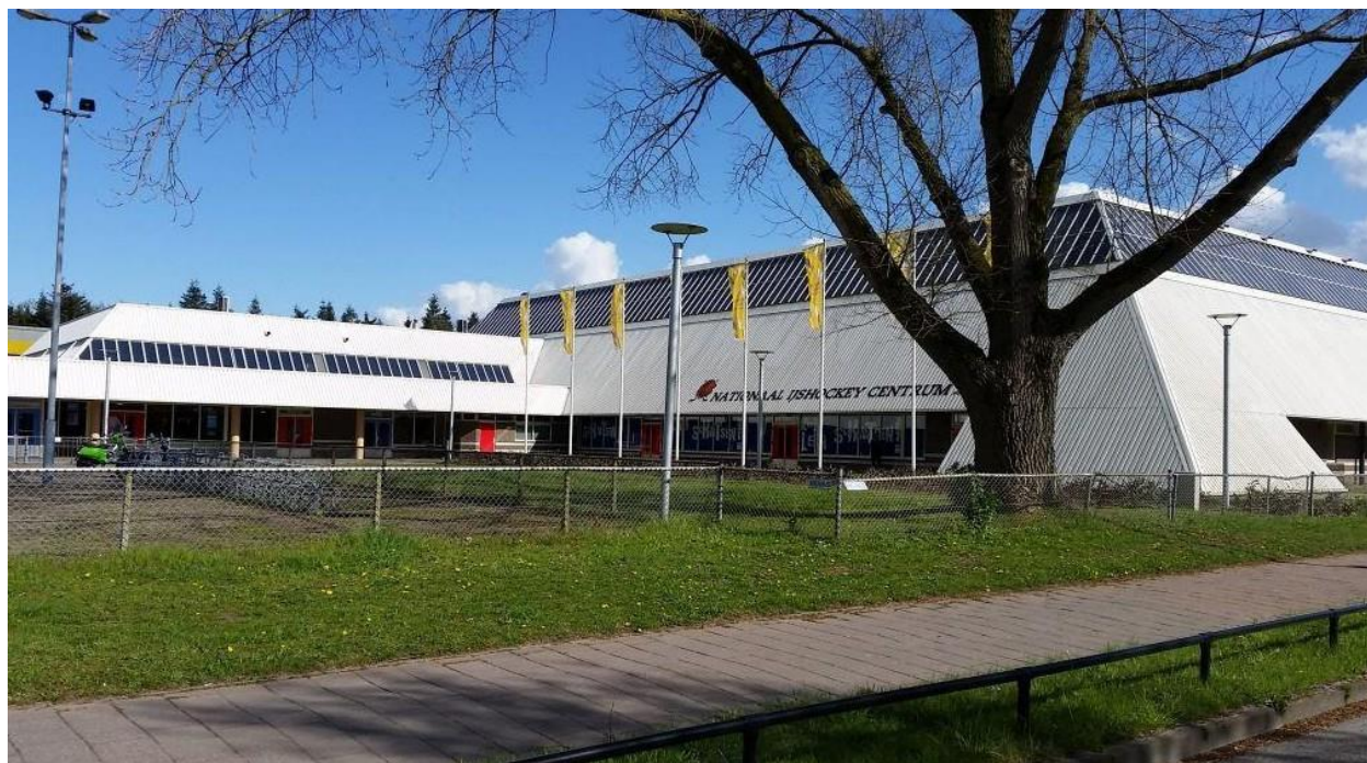
Slika 1. Ledena hala i Bazen revirzibilno hlađenje - grijanje Rotterdam NL
