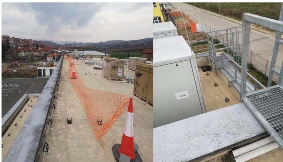
Slika 1. Obezbeđenje pristupa gradilištu
