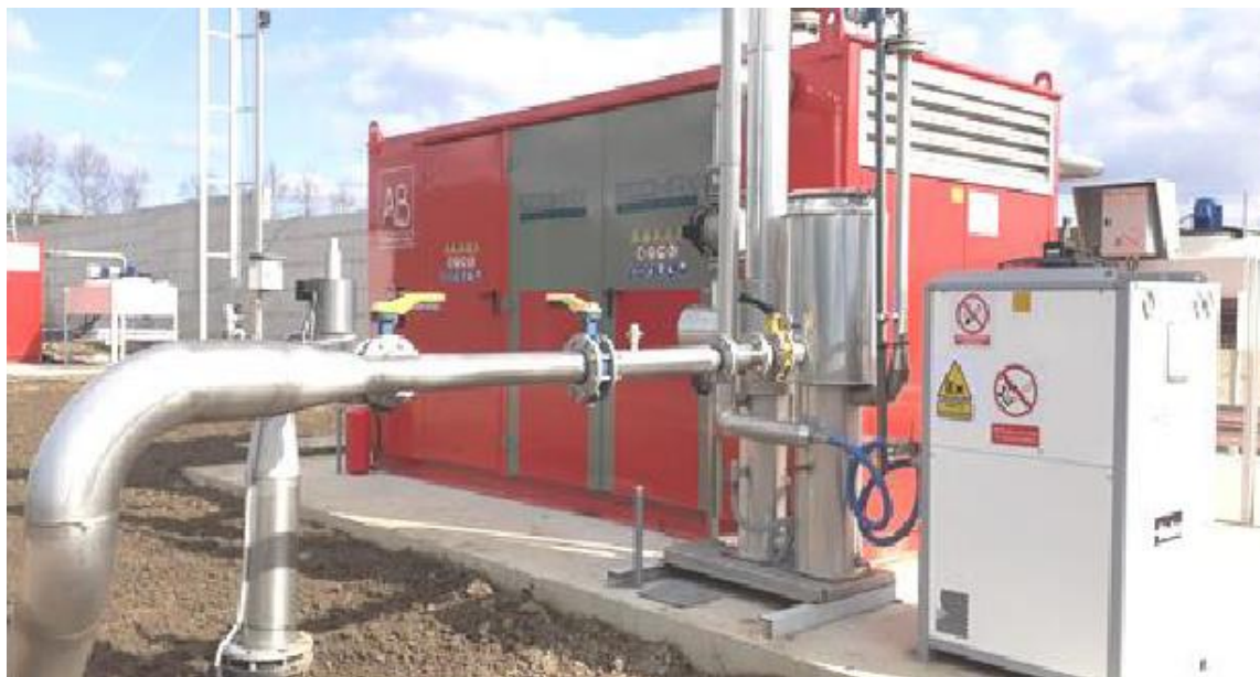
Slika 1. Blokmotor sa generatorom u kontejneru tip „ECOMAX 1,5 - BIOGAS“ (Čehajić, Fejić, Karić, Muminović i Omerović, 2023)
