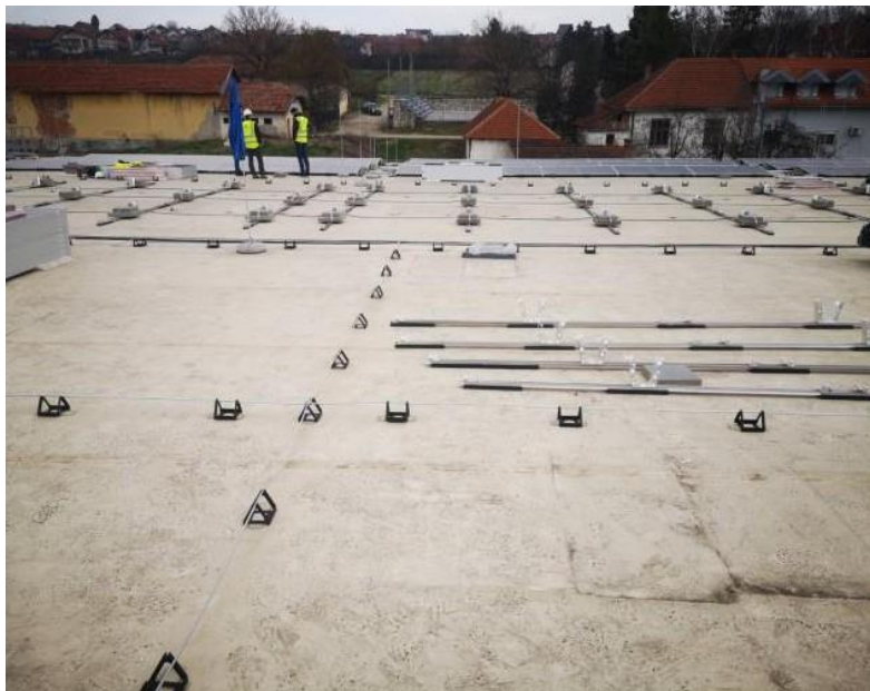
Slika 3. Pozicije kablova na mestima gde se postavljaju solarni paneli
